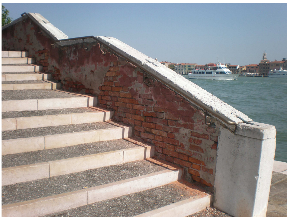
Fig. 13_ Ponte di Sant'Eufemia nuovo corrimano realizzato su progetto concordato con la Soprintendenza per i Beni Architettonici per il Paesaggio e per il Patrimonio Storico Artistico di Venezia e Laguna.
