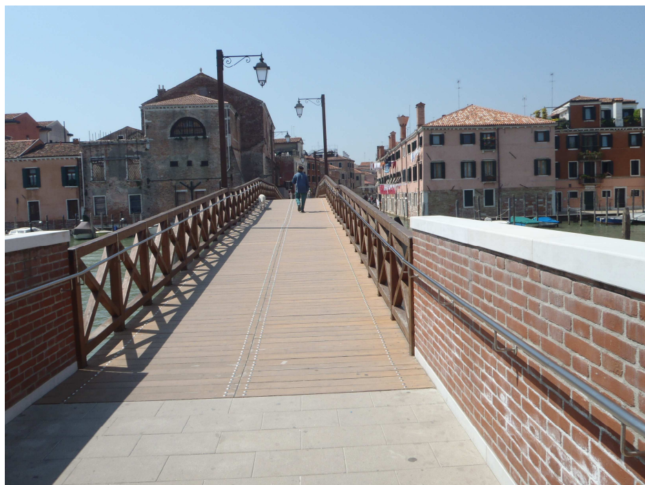
Fig. 9_ Nuovo ponte di Quintavalle a Castello; ponte accessibile privo di gradini.
