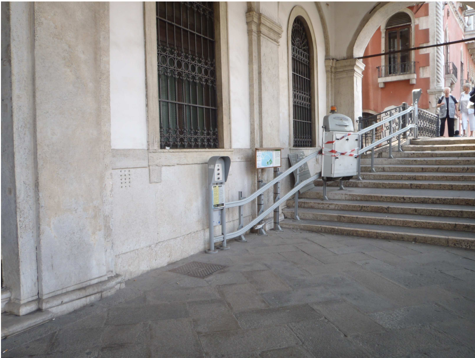
Fig. 1_ Ponte della Banca d'Italia; servoscala attualmente rimosso
